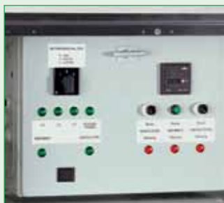
Rozvodná skříň s počítadlem provozních hodin s uzamykatelnými dvířky
